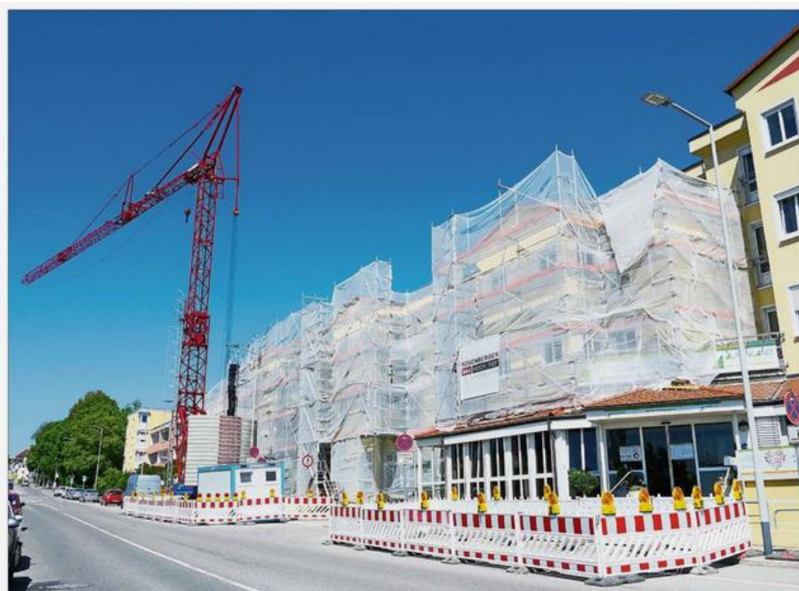
Das Gerüst steht, die Aufstockung läuft: Das Pflegeheim am Deutenberg wird vergrößert.
